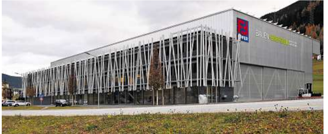
Wissen und Informationen auf drei Stockwerken: Das Kompetenzzentrum Bauen und Energie in Savognin steht allen Interessierten offen.
