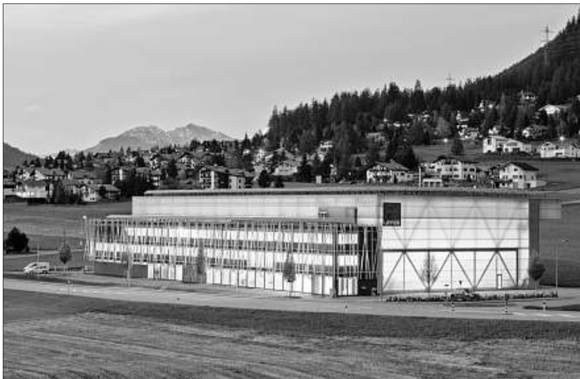
Ein «leuchtendes Beispiel»: Im Uffer House wird auch bei voller Produktion in der Werkhalle nicht mehr Energie verbraucht als im Gebäude selber produziert wird. (zVg)
