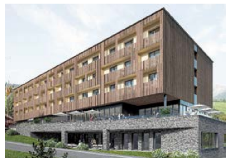
Das erste Jufa-Hotel in der Schweiz ist ein Holzmodulbau. Uffer AG
