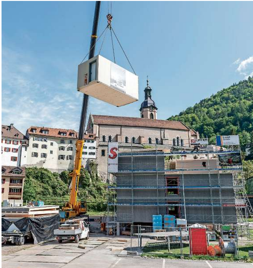
Aufeinandergeschichtet und funktional eingerichtet: Die Quadrin-Module am Plessurquai werden zur temporären Studentenunterkunft zusammengebaut. Bilder Yanik Bürkli
